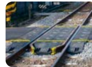
再生プラスチック製の踏切板
