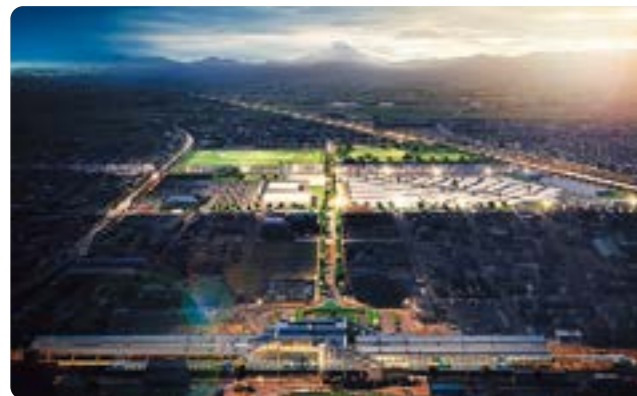
BRIDGE LIFE Platform 南栗橋 夕景
