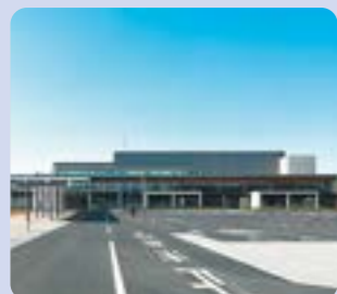
庁舎建設工事 (東武建設)
