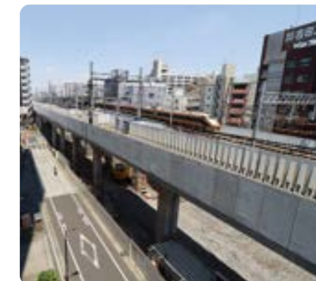
FRP製遮音壁(高欄)
